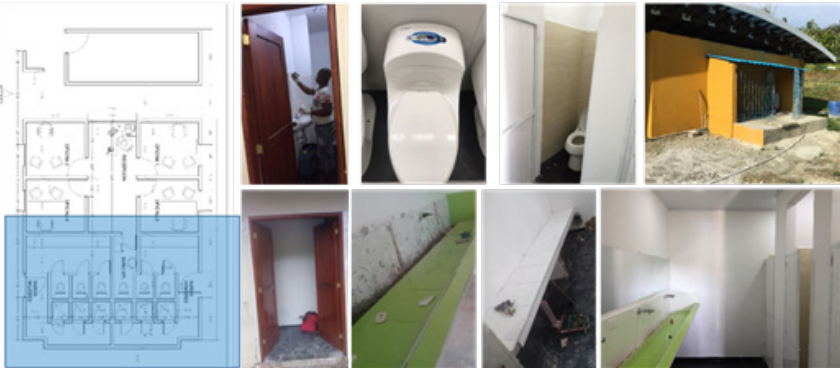
Foto: Mantenimiento y adecuación de los baños de la Dirección de Bienestar Universitario.
